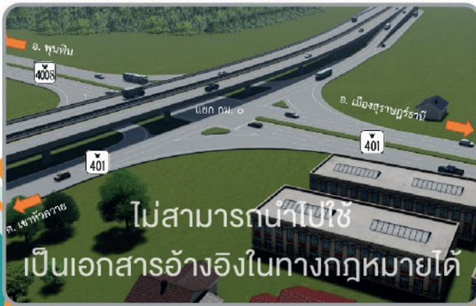
สะพานรูปแบบสะพานต่างระดับ ข้ามแยก ทล.401 หรือ เรียกแยก กม.0
